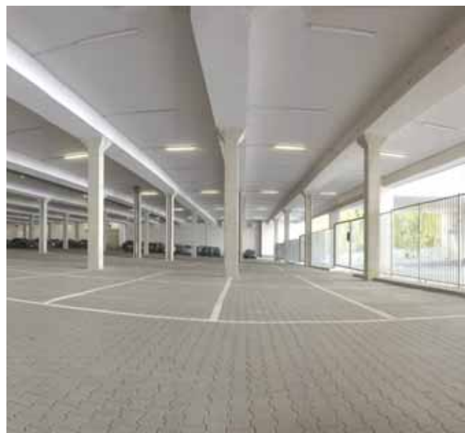
Garaža u poslovnom objektu
