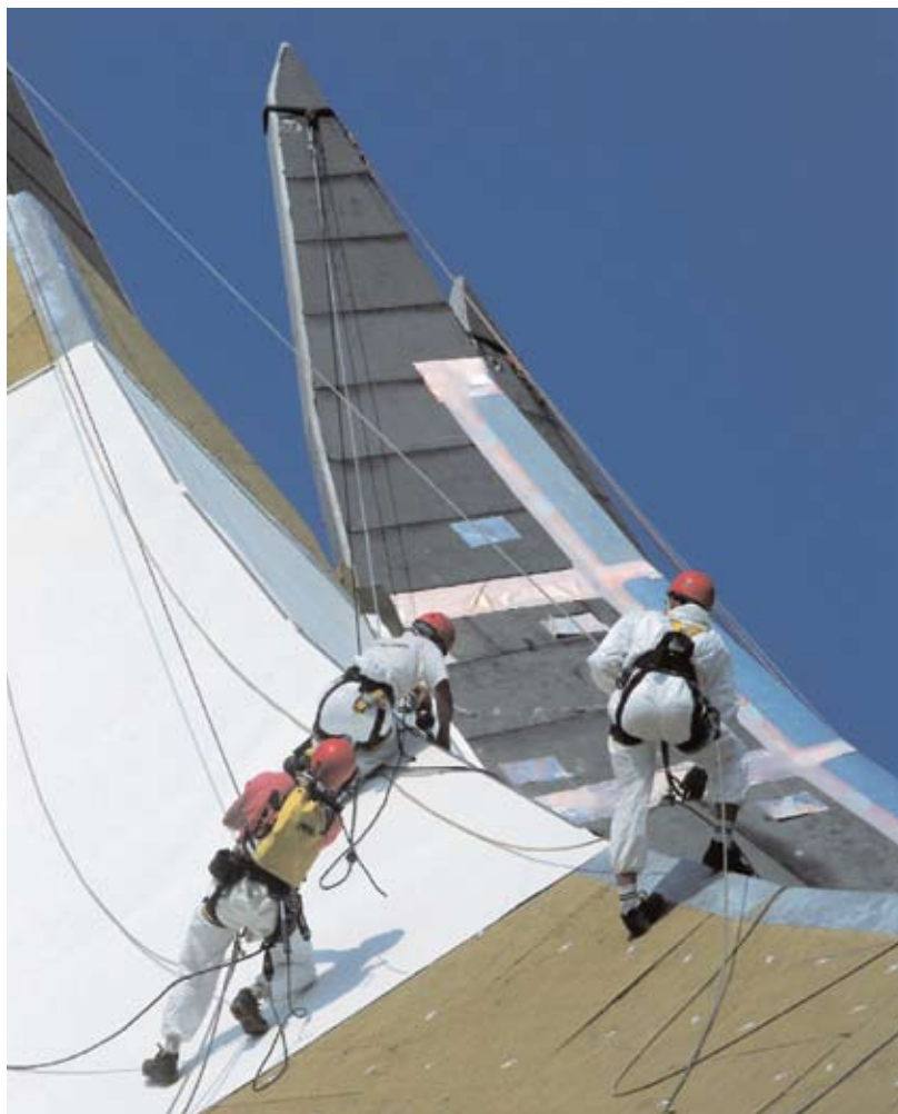
Postavljanje membrane na objektu Tempodrom, Nemačka
