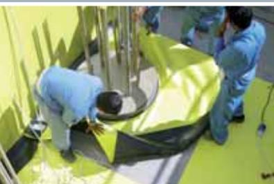
Detalji membrana za hidroizolaciju
