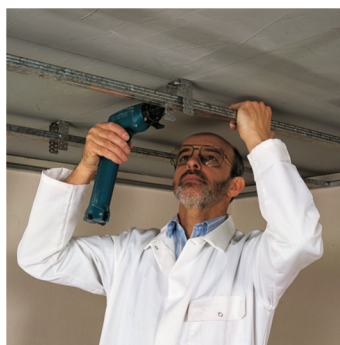
Profili se šrafe za distancer vijcima sa širokom glavom.
