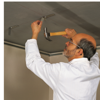
Rigips distanceri montiraju se na plafon pomoću šrafova sa metalnim tiplom.
