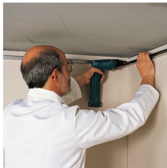
Rigips UD-profil oblaže se trakom za zvučnu izolaciju i montira se na zid.
