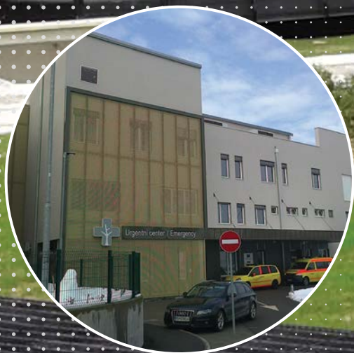
Splošna bolnišnica Brežice
