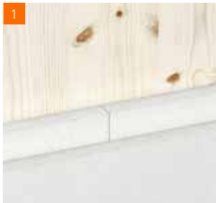
1 Direkt Beplankung auf Massivholz/Brettsper Holz (alternativ Holzwerkstoffplatten)
