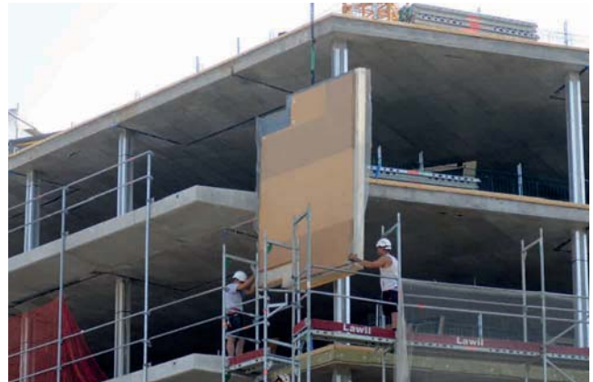
Montage vorgefertigter Bauteile; Holzrahmenbau
